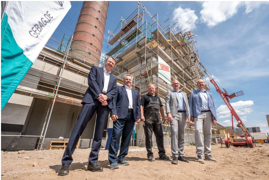
Richtfest für die Energiezentrale im zukünftigen Technologie-Quartier Wedau-Nord (v.r.): GEBAG-Geschäftsführer Bernd Wortmeyer, Duisburgs Oberbürgermeister Sören Link, Dachdecker Dirk Pews, Bruno Sagurna (Aufsichtsratsvorsitzender GEBAG), Marcus Vunic (Geschäftsführer Duisburger Versorgungs- und Verkehrsgesellschaft). (Foto: Uwe Köppen)
